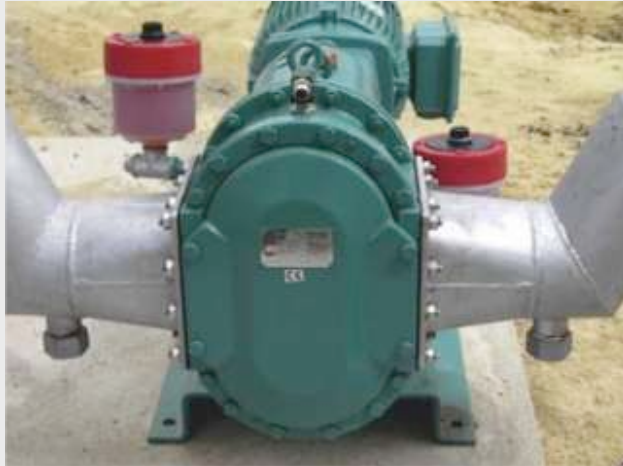
Bomba de alimentación para sustrato en planta de biogas Caudal hasta 40 m 3 /h a presiones hasta 2 bar.
