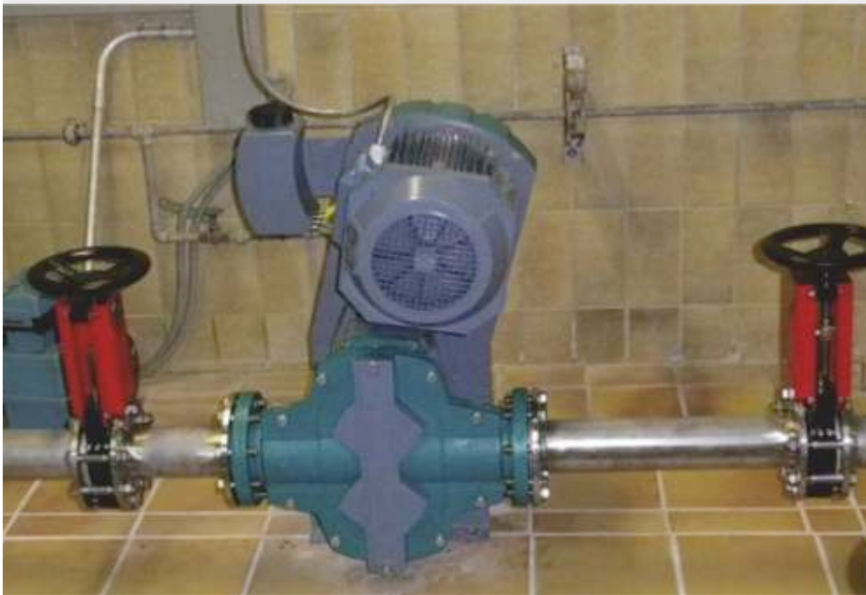
Utilizada en planta de tratamiento de efluentes, la TORNADO® T2 bombea lodo con 2% contenido de sólidos a una capacidad hasta 18 m 3 /h contra una presión hasta 2 bar.
